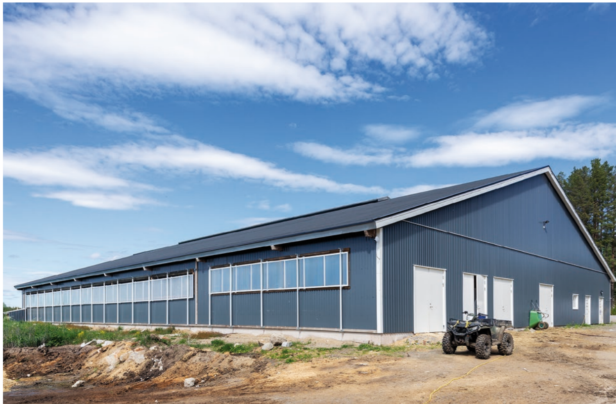
LANTBRUKSBYGGNAD BURSILJUM. När Tångås Lantbruk skulle bygga nytt föll valet på en pelar-balklösning, där miljöfördelarna går hand i hand med gårdens ekologiska verksamhet.
