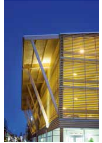
Martinsons levererade stommen till Sveriges första parkeringshus i limträ, beläget i trästaden Skellefteå.
