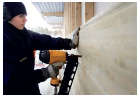
Enkel montering En limträpanel monteras precis som en vanlig panel, med spik eller skruv. Genom att välja en panel med ändspont kan montaget utföras ännu mer effektivt.
